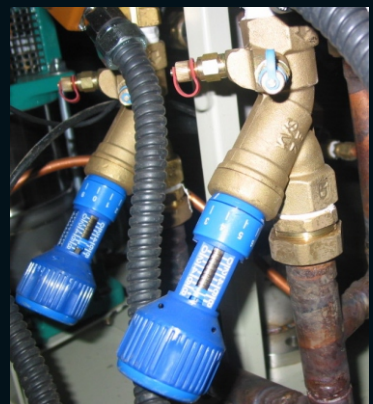
사진 22:[발란싱 밸브]각유체 회로 마다 발란싱 밸브를 설치하여 유량의 균형을 유지하고 미세 조정이 가능 하도록 하였으며 통수 시 소음을 최소화 노력하였다.
