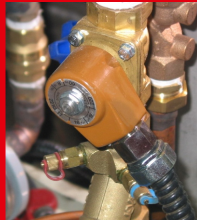
사진 21: 솔레노이드 밸브 압력 :PN 10 Bar
